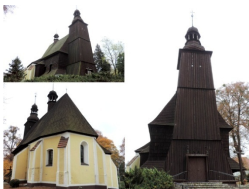
Fot. 1. Sieroty. Kościół parafialny p.w. Wszystkich Świętych (foto źródło: Gminna Ewidencja Zabytków).
